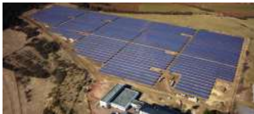
Bürger Solar-Anlage Wachenbrunn, fotografiert von unserer EGIS-Drohne
