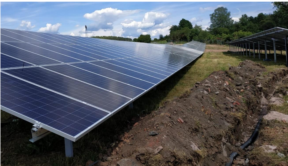
Abb. 6: Modulreihe in Themar mit Stromkabelkanal
