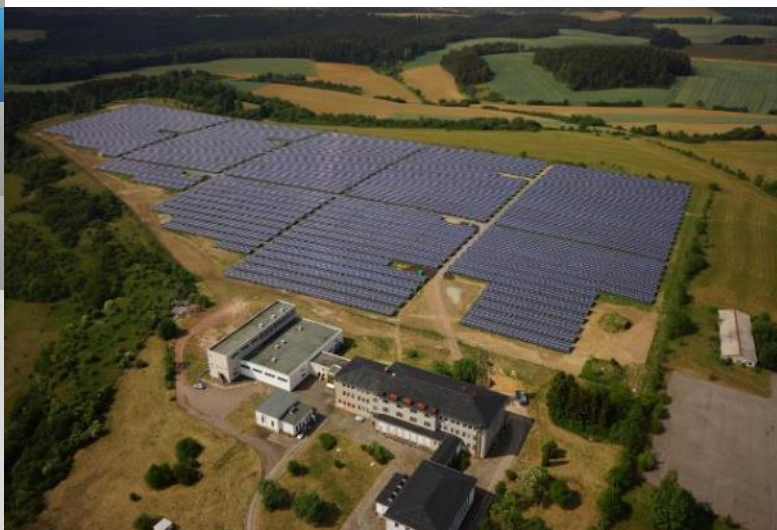
8,7 MWp Bürgersolaranlage Wachenbrunn / Thüringen
