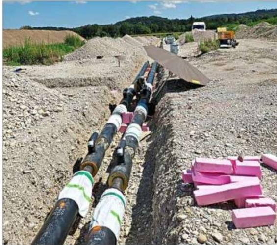
Wie hier in Emmerting will die EGIS auch in Garching beim Fernwärmenetz stark isolierte Stahlrohre unterirdisch verlegen. Durch die Rohre fließt als Arbeitsmedium gereinigtes Wasser. Weil es ein geschlossener Kreislauf ist, werden die Rohre immer paarweise verlegt. – Foto: EGIS
