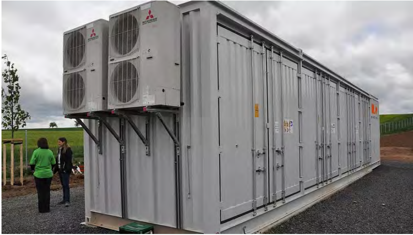
Foto: Martin Schweiger | Das macht Reckertshausen zum Vorreiter in ganz Deutschland: Batteriespeicher (im Bild) speichern den erzeugten Solarstrom.
