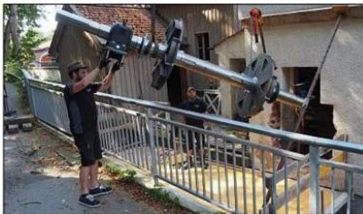
Das Herrenmühlen-Wasserrad wurde von der EGIS auf Energieerzeugung umgerüstet, den gewonnenen Strom nimmt der Kreisjugendring in seiner Geschäftsstelle ab. Unser Bild entstand im September 2016 bei der Vorbereitung zum Einbau der Antriebswelle durch eine Spezialfirma aus Bad Kissingen. – Foto: Schwarz
