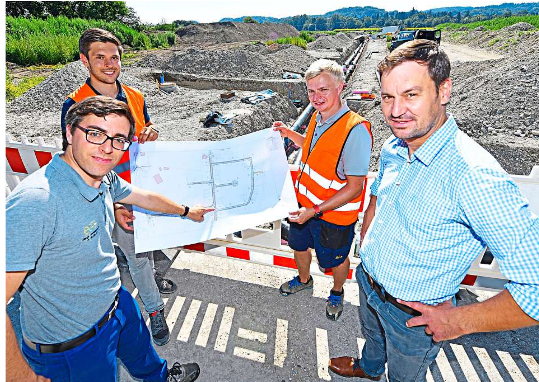
Überzeugen sich vor Ort vom Baufortschritt: Pascal Lang, Vorstand EGIS eG (vo. li.) und 1. Bürgermeister Stefan Kammergruber (re.).
