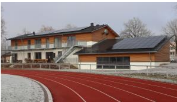
Abbildung 3: PV-Anlage auf dem "Haus des Sportes" beim TV 1864 Altötting e.V.
