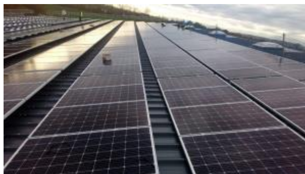
Abbildung 2: Installateure bei der Arbeit
