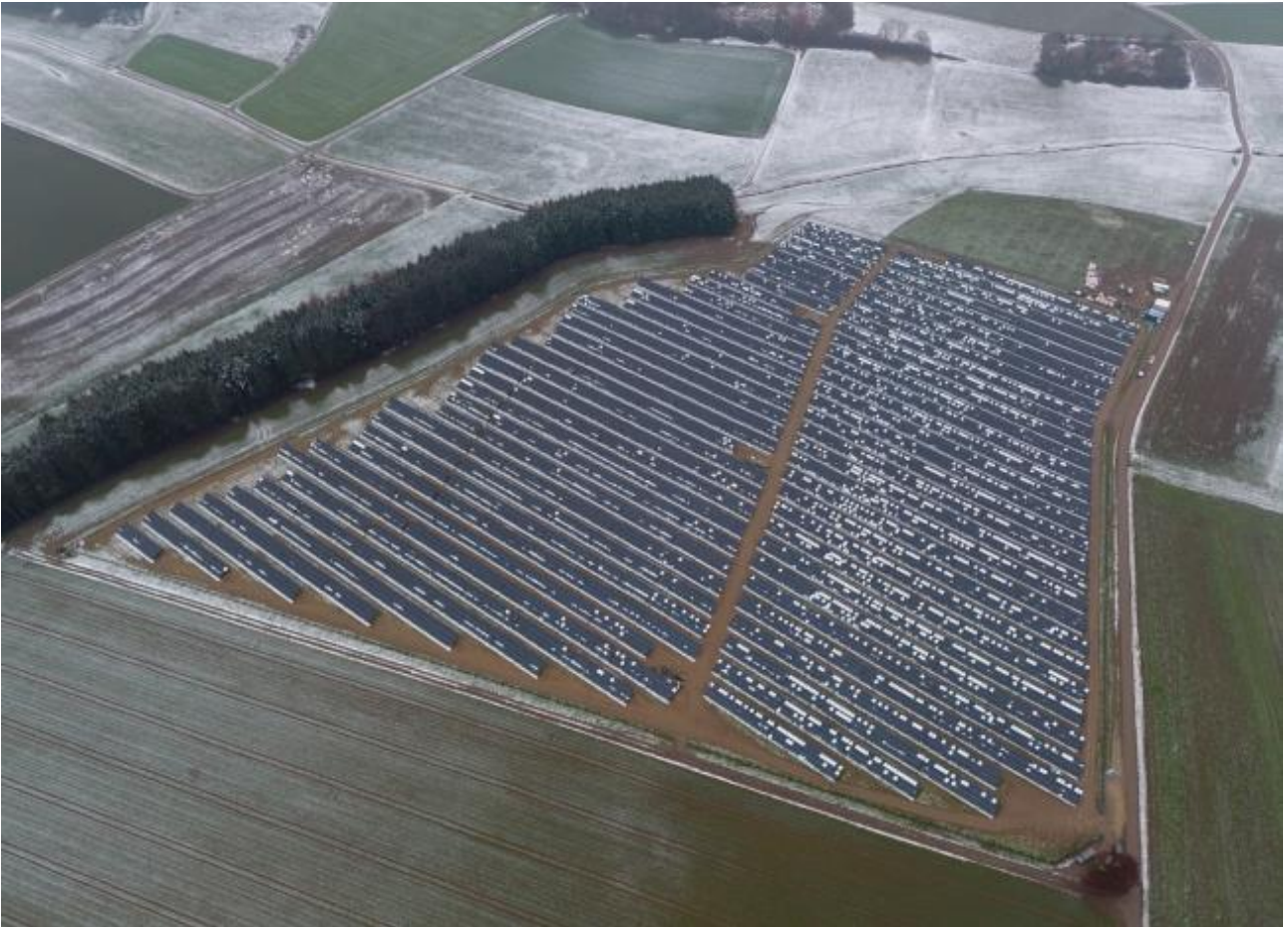
Luftbild PV-Park Aichen der EGIS eG (Quelle: MaxSolar GmbH)
