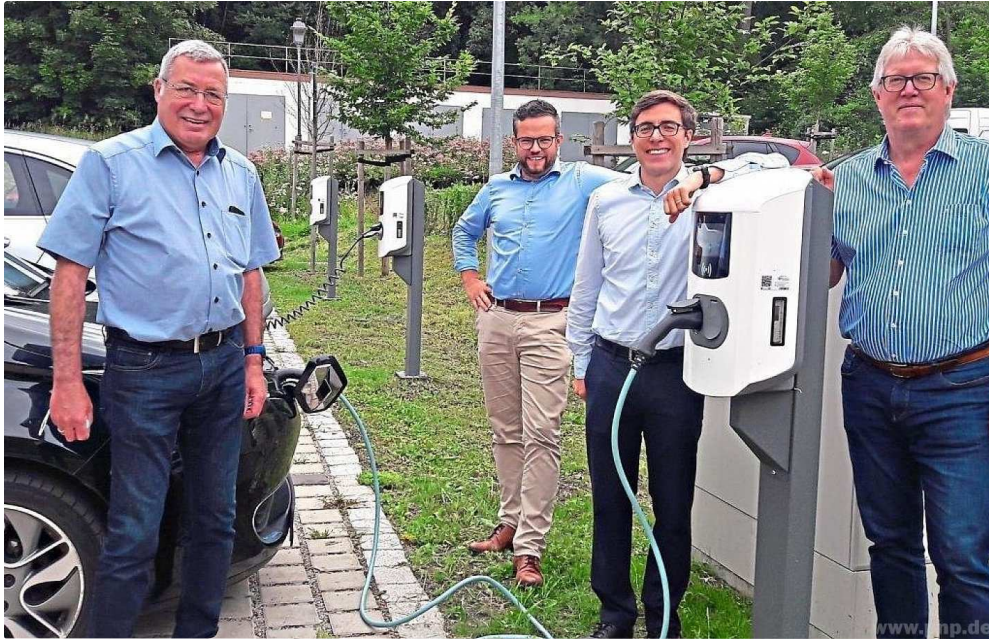
Stecker rein und Strom tanken – drei Ladesäulen mit je zwei Stationen gibt es jetzt am Parkplatz West unterhalb des Stadtmuseums. Am Freitag haben Bürgermeister Peter Haugeneder, Christoph Strasser und Pascal Lang von der Egis und Bauamtsleiter Alois Schötz das neue Angebot offiziell in Betrieb genommen. –Foto: Lambach
