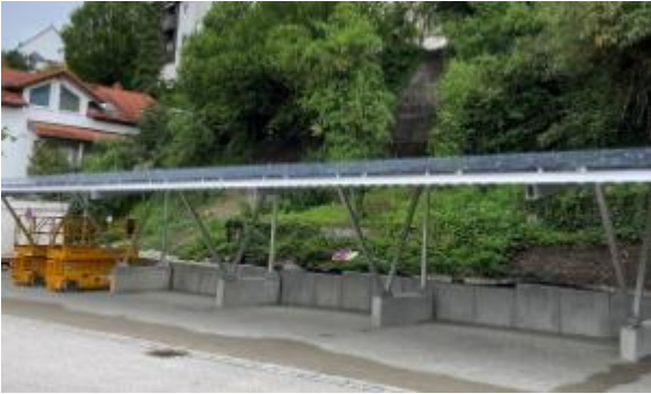
Abbildung 1: Carportanlage Rathaus Neuötting
