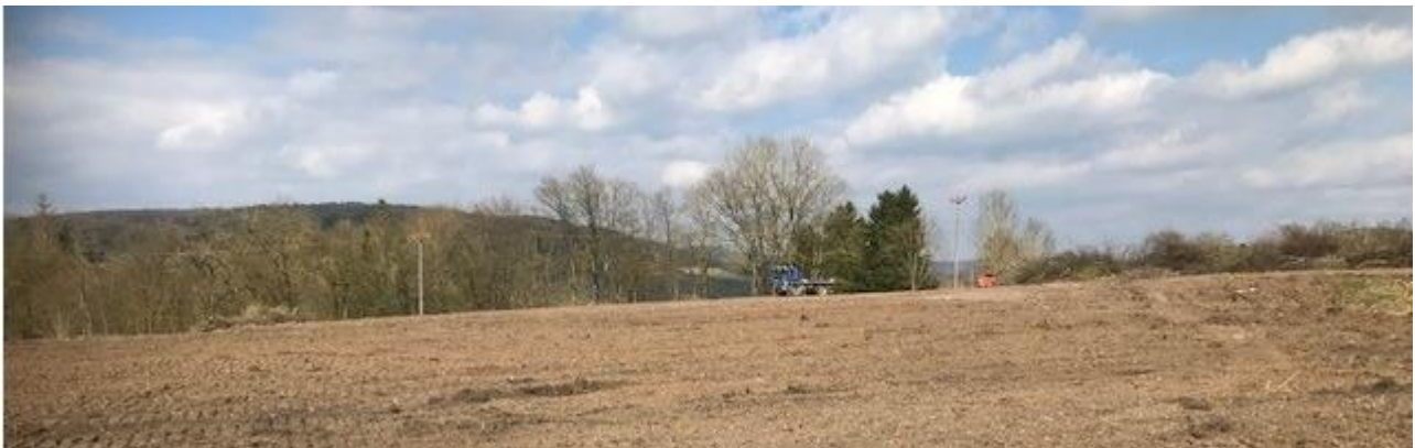
Abbildung 1: Themar nach den Vorbereitungsmaßnahmen für den Bau der Photovoltaik-Anlage
