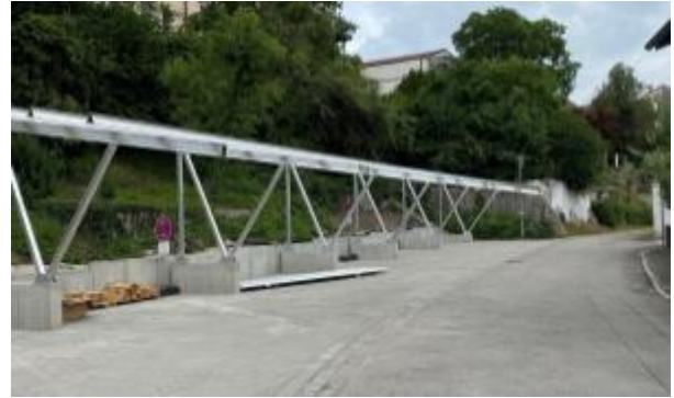
Abbildung 2: Carportanlage Rathaus Neuötting in der Bauphase
